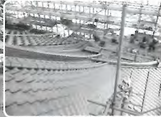
見下ろした屋根
